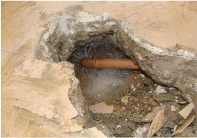
Figura 1. Vazamento não aparente.
